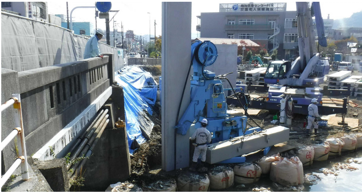
初期圧入状況
