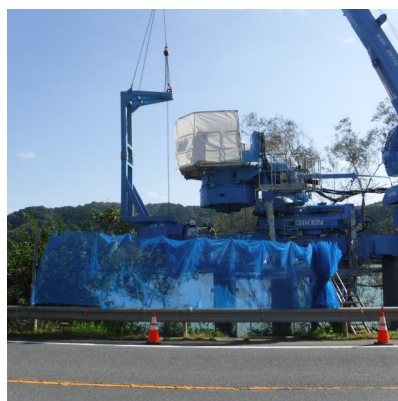
ステップロック設置状況
