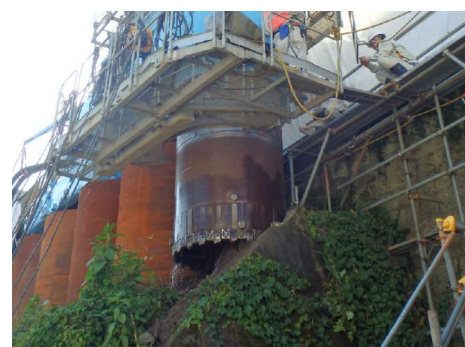
擁壁削孔状況
