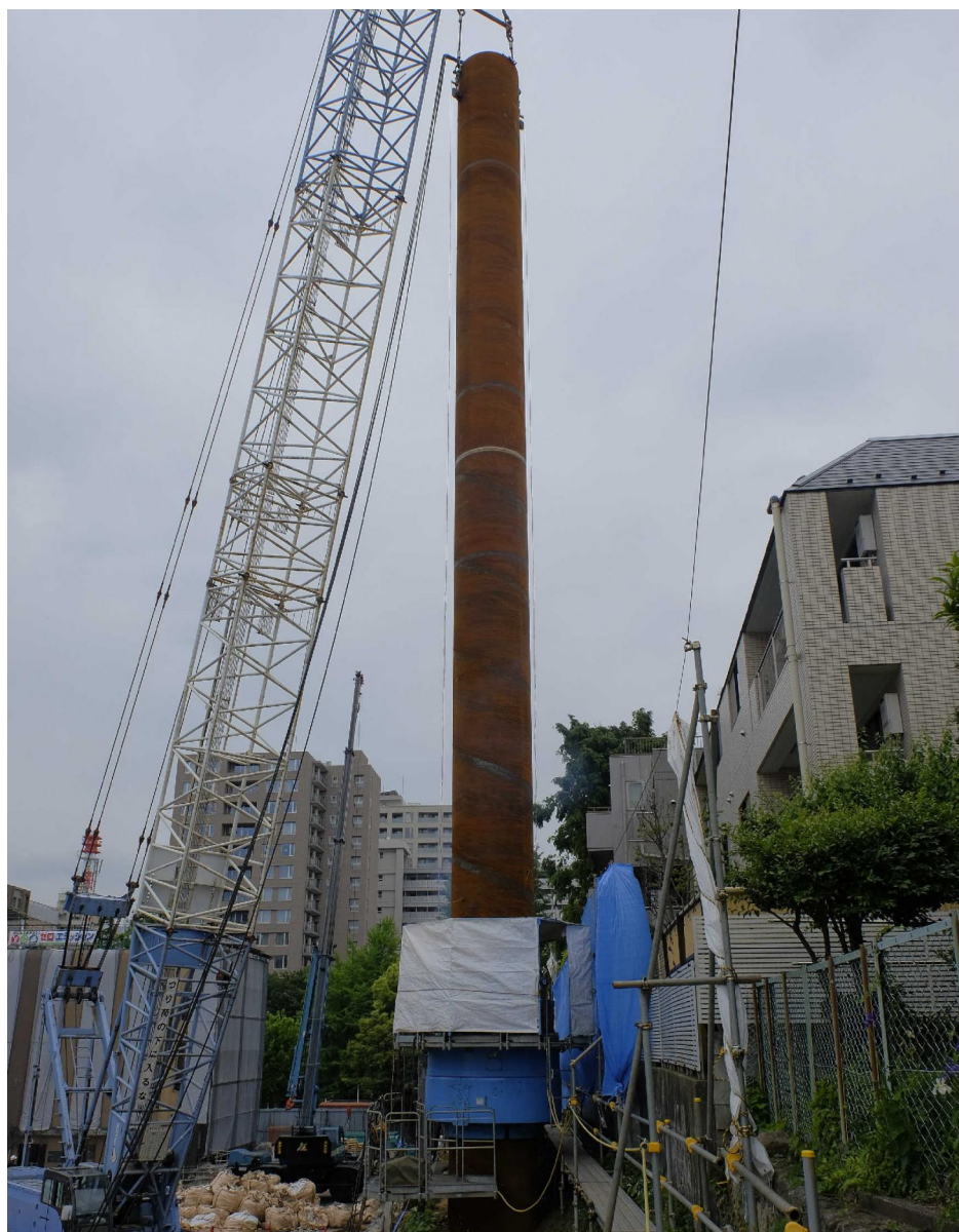
鋼管杭圧入状況
