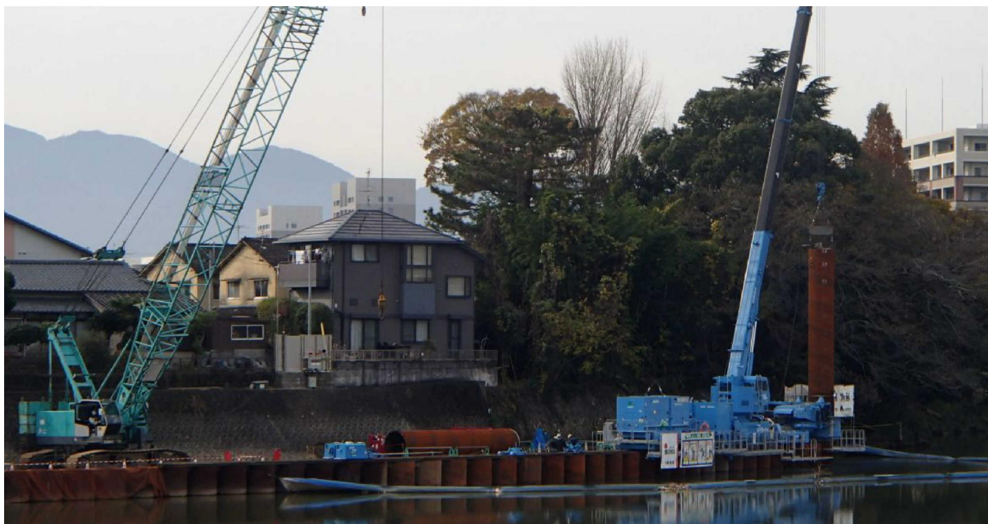
全体施工状況
