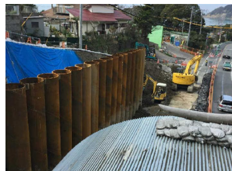
鋼管杭圧入完了後
