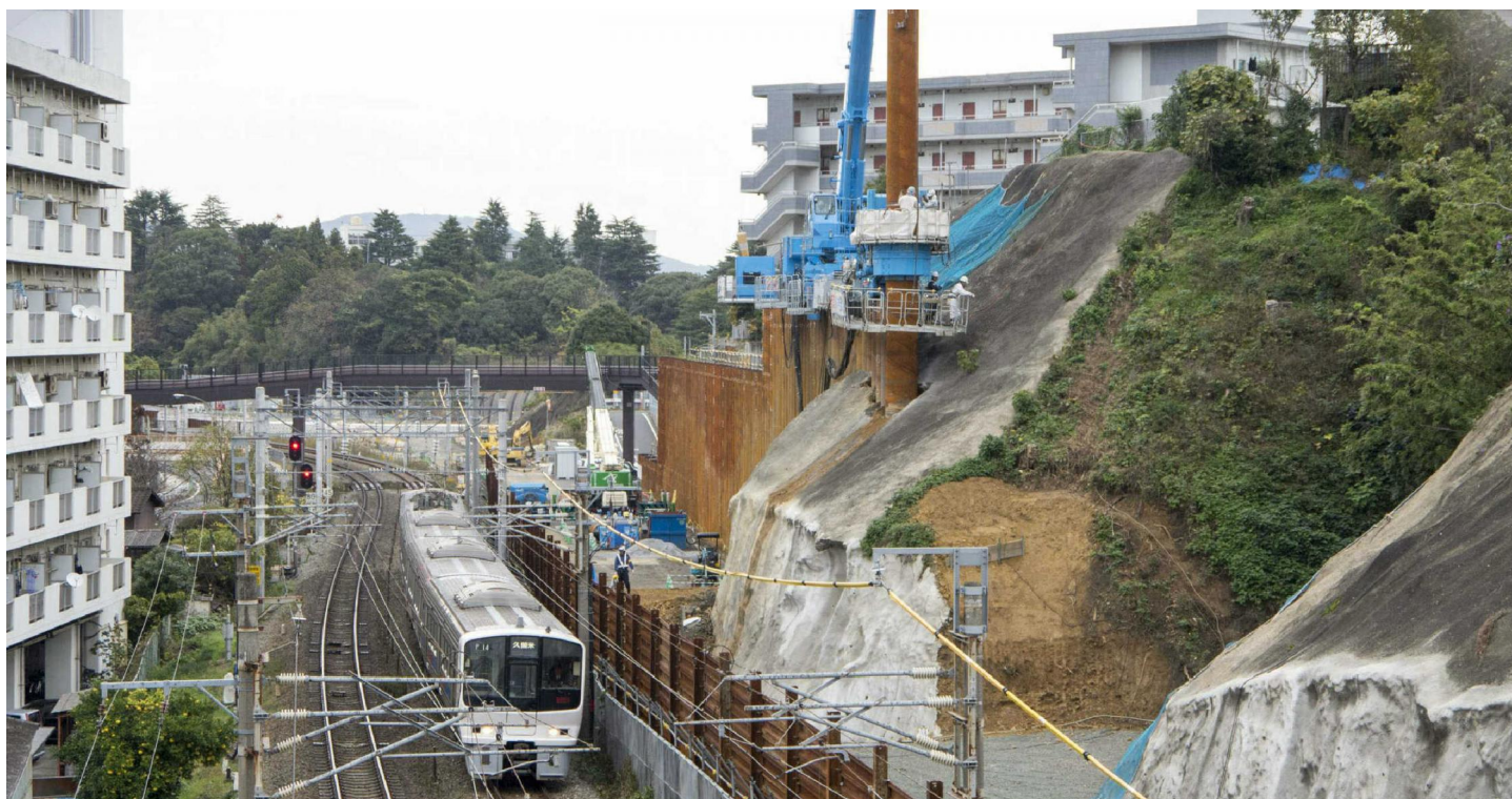
営業線近接施工
