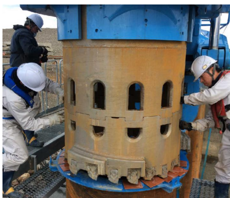
先行杭ヘッド部
