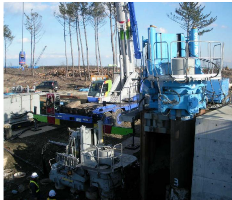
同工区内での複数台施工
