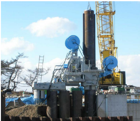
既設水門に干渉しないよう嵩上げて施工
