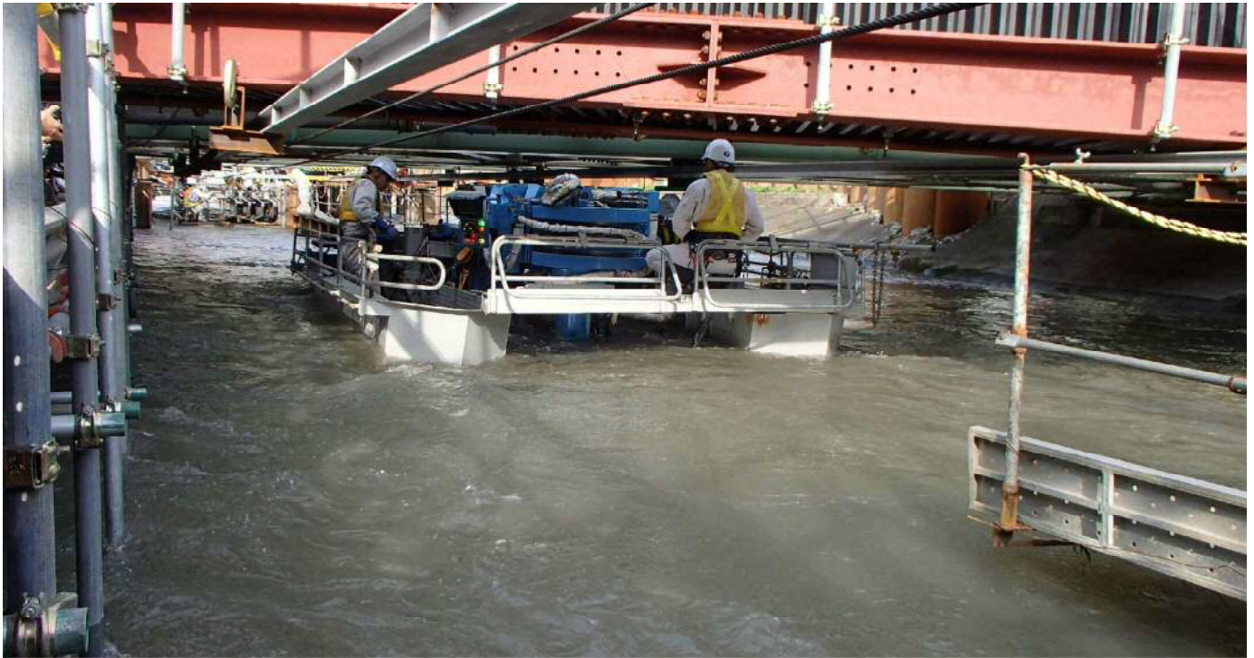
桁下施工状況
