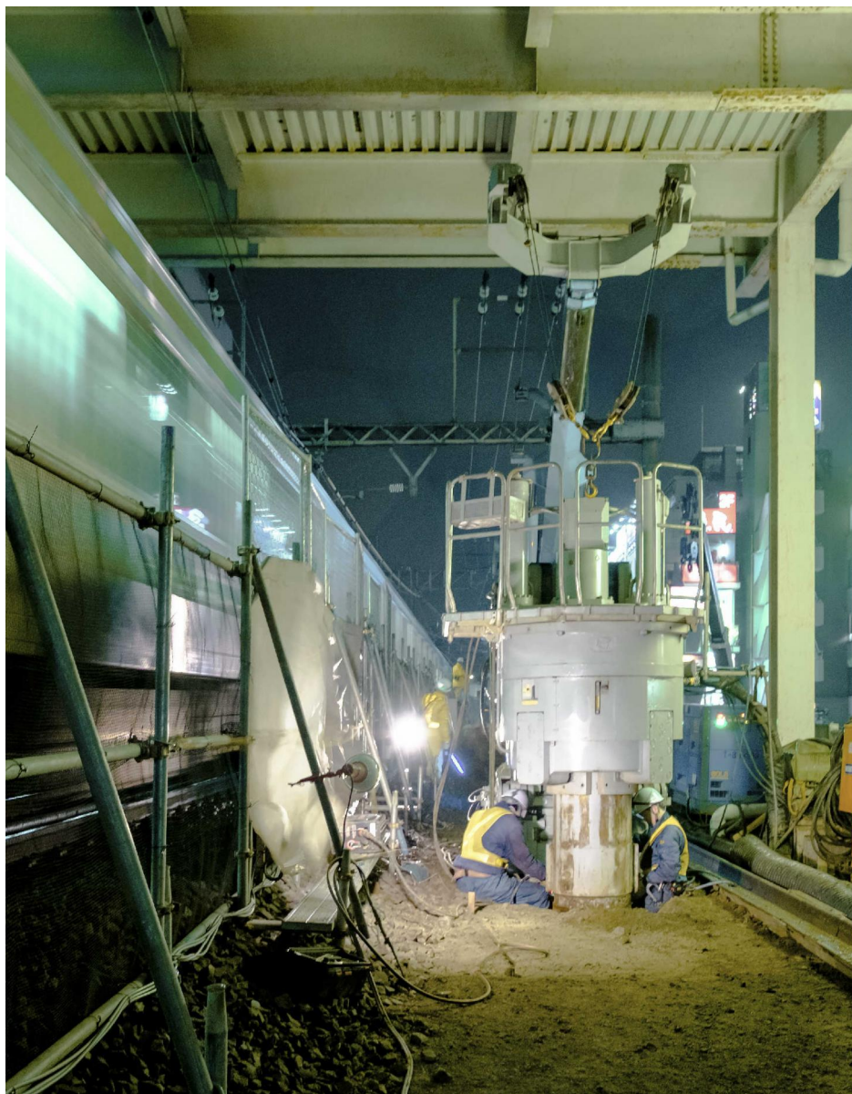
通常施工状況
