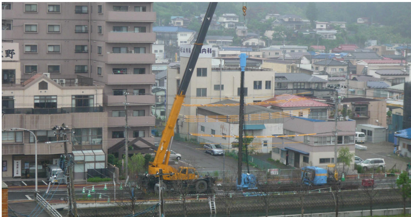
施工全体状況(夜間は道路開放)
