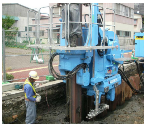
鋼矢板圧入状況
