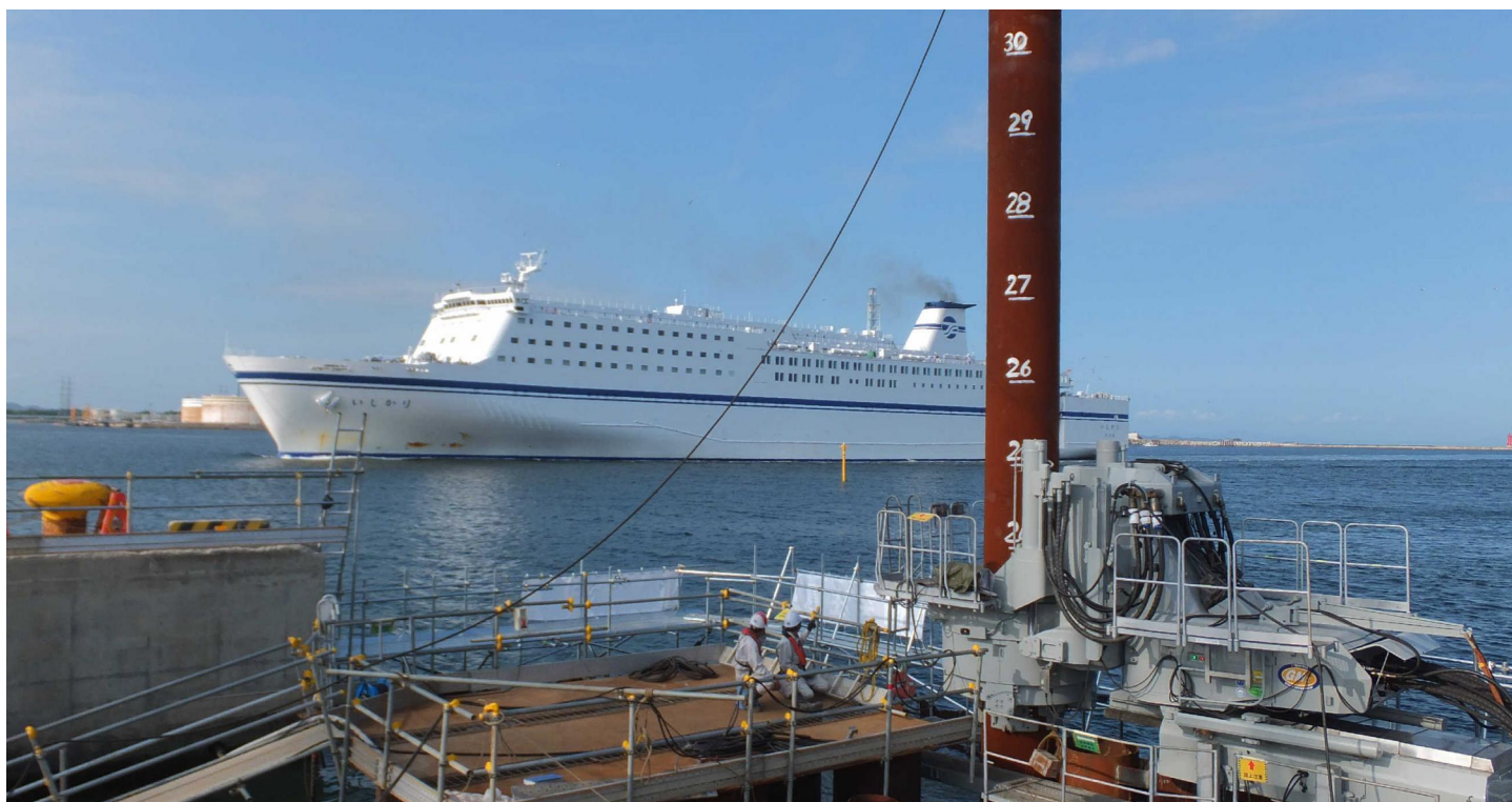
港湾機能を損なわず、圧入施工が可能
