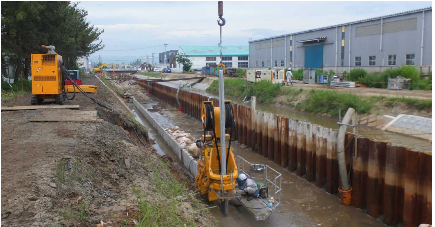
圧入施工状況
