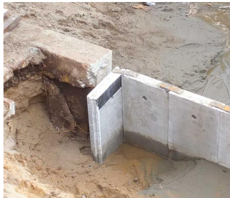
端部処理状況
