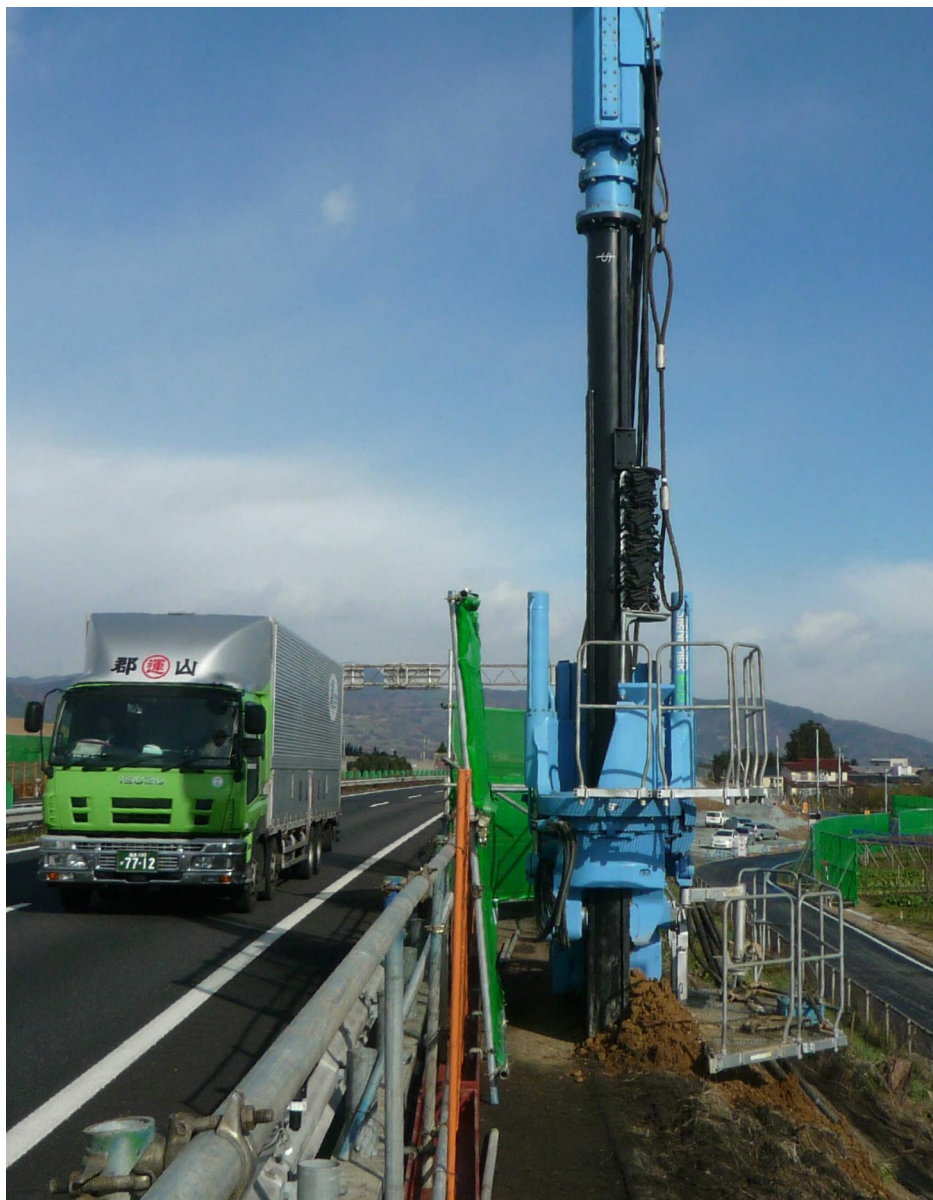
高速道路脇での近接施工
