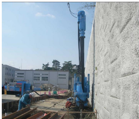
【近接施工状況】
