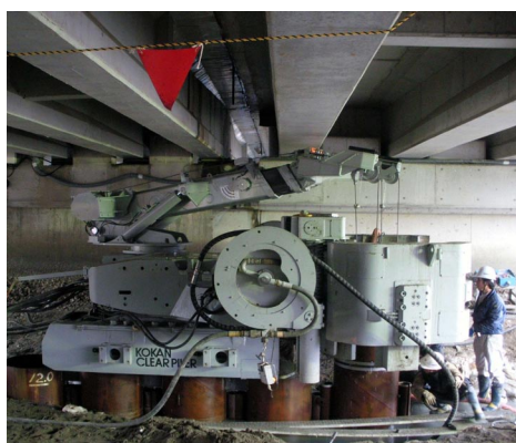
鋼管矢板吊込み
