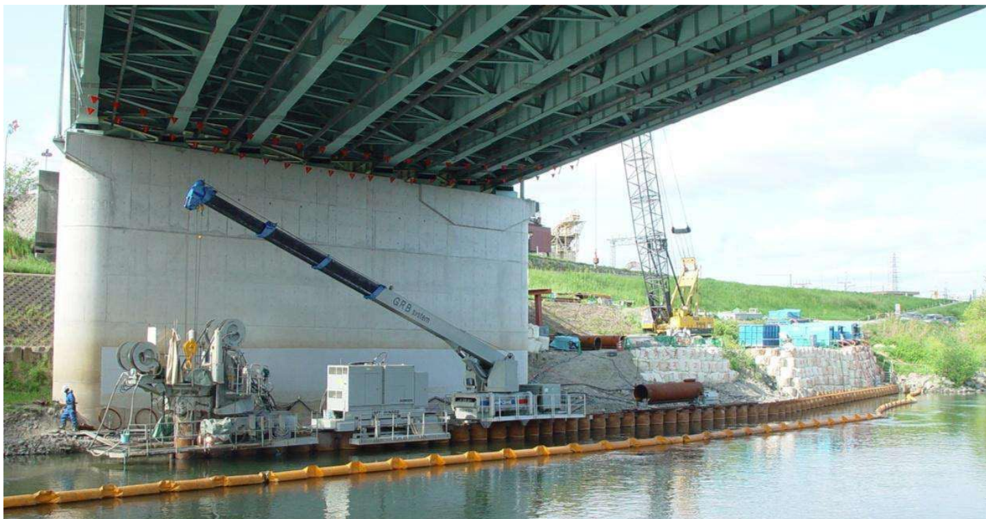
GRBシステム施工
