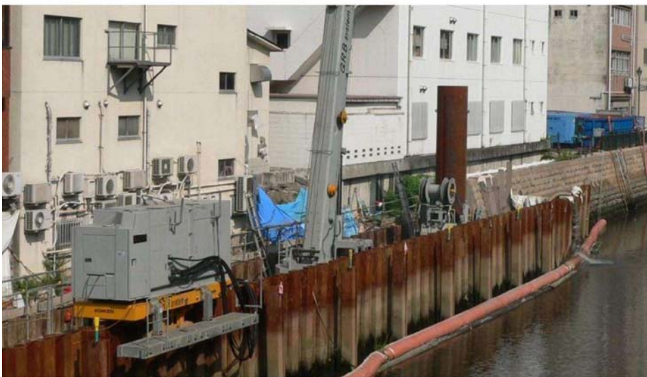
▲仮締切内の圧入施工状況
