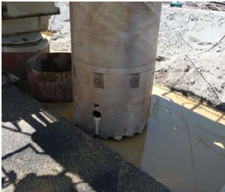
先行削孔作業
