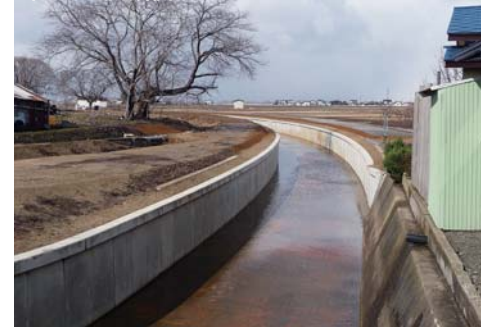
第三工区完成後
