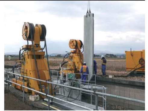
▲複数台施工により工期を短縮
