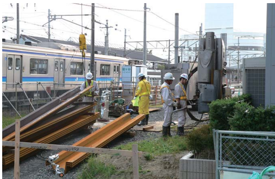
▲ 現場は道路・宅地・鉄道に囲まれた狭隘地
