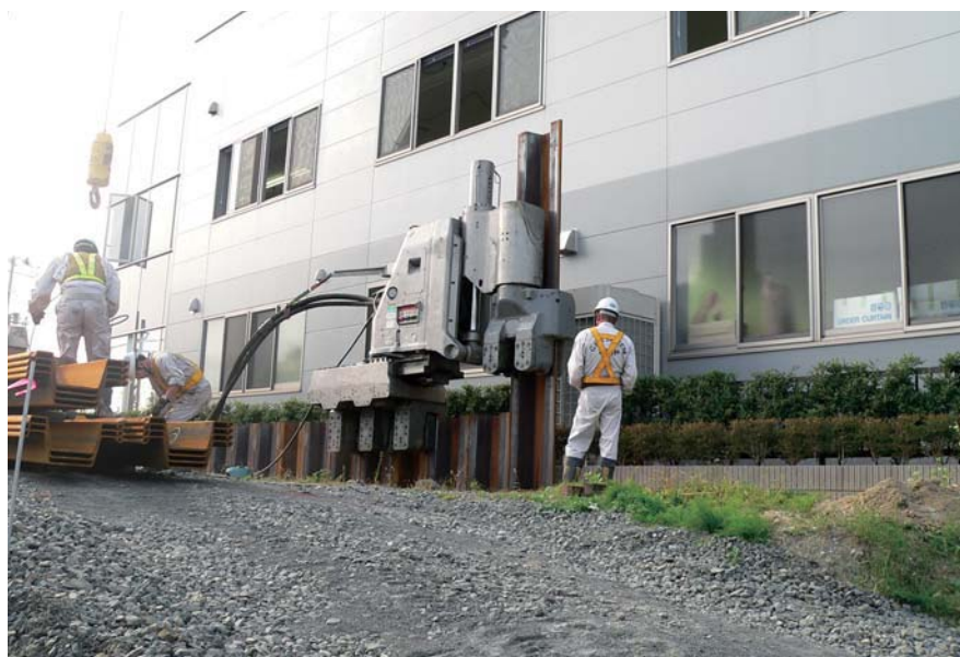
▲ 民地に対するの超近接施工
