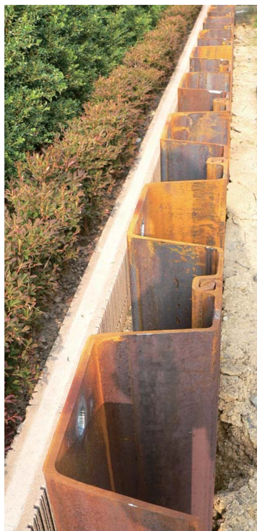
▲ 近接構造物に対する高い施工精度
