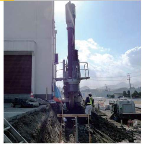
▲ 構造物に近接 (離隔1.0m) して施工可能
