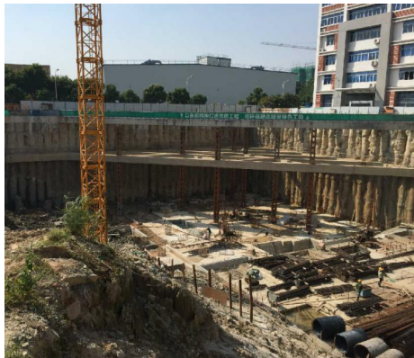
施工后止水效果
