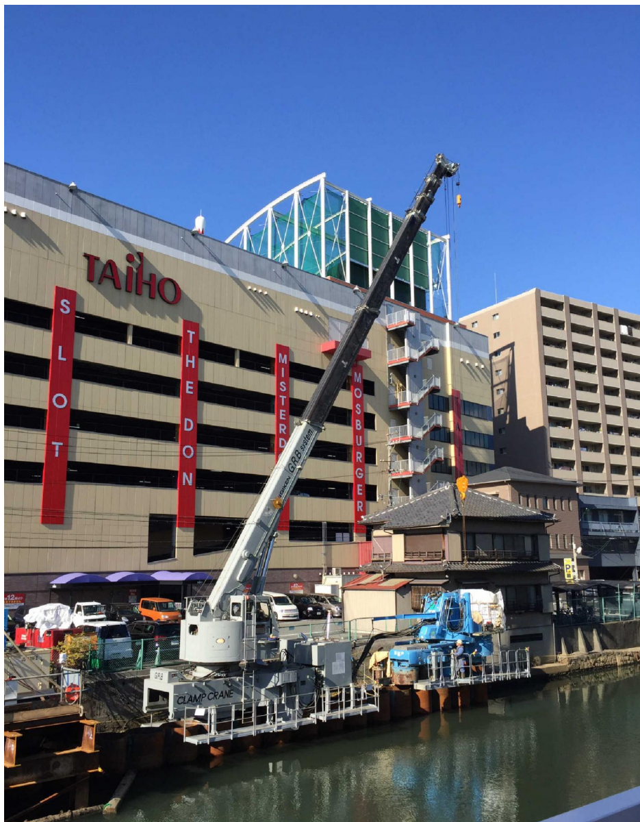
GRBシステム施工（クランプクレーンCB4）
