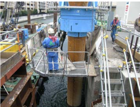
既存橋台に接近しての作業
