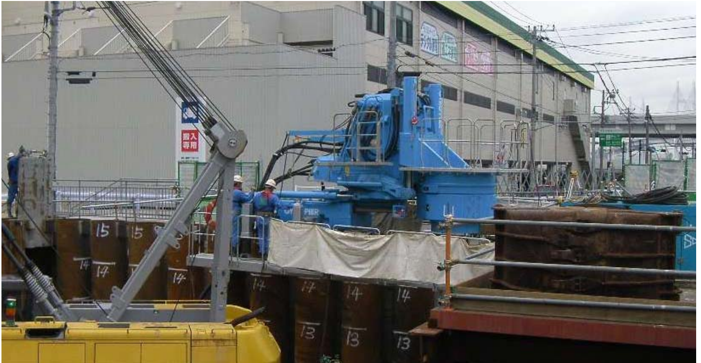
台船を使用しての施工施工状況
