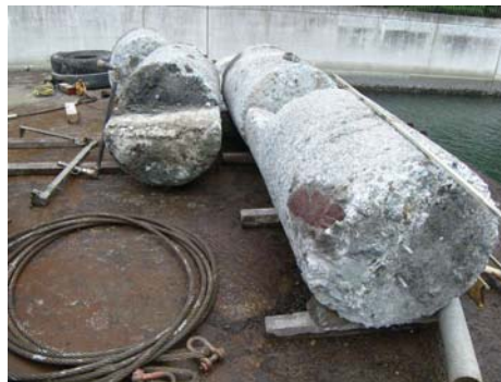
先行削孔杭にて撤去された既存橋台フーチング
