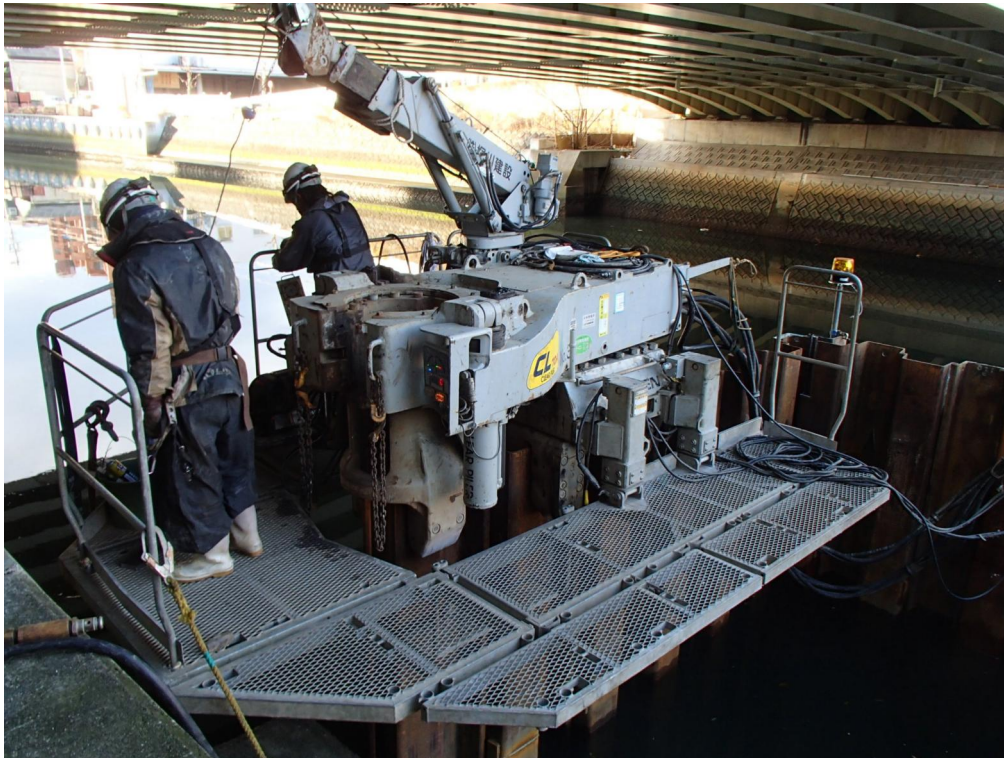
橋梁下部におけるクリア施工状況
