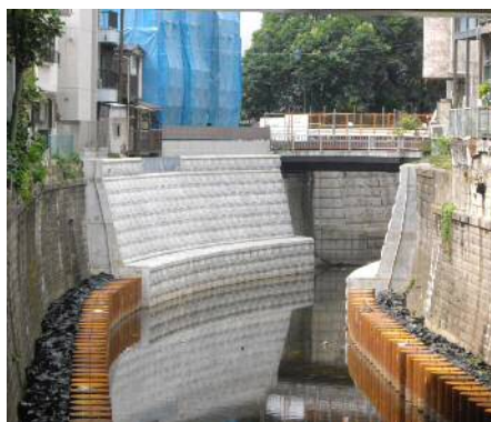
▲施工後護岸完成
