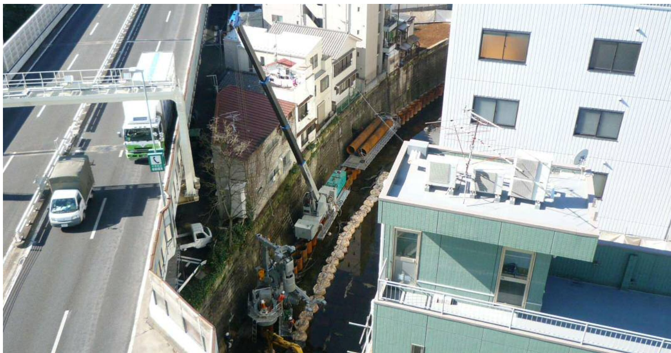
▲首都高速道路下でのシステム施工状況図
