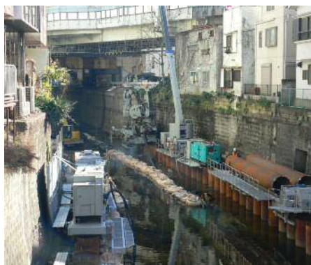
▲システム施工状況
