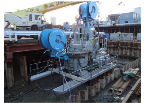
組立完了状況
