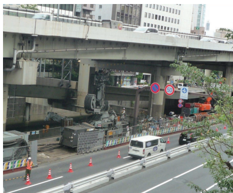
△車線規制状況
