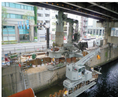
△締切り矢板上からの建込み
