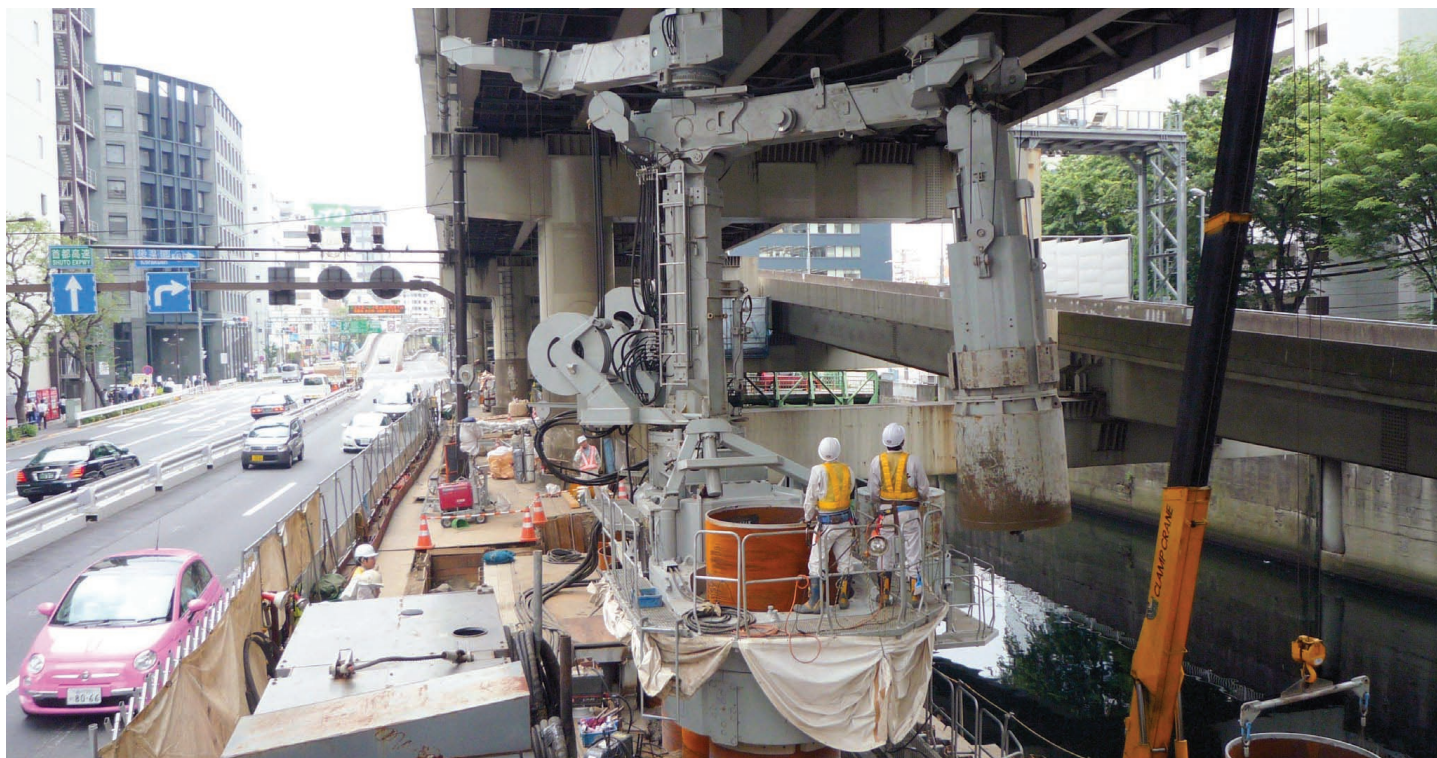
△上空障害下・車線規制脇での施工状況
