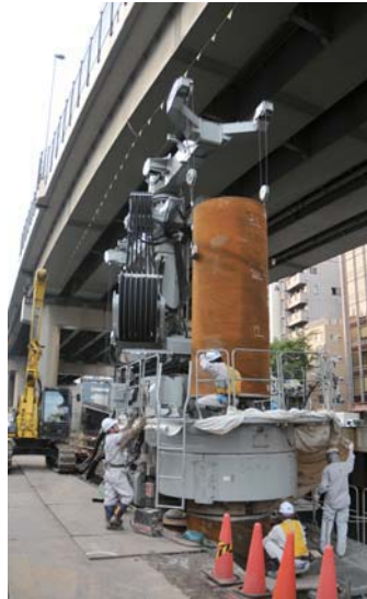
▲ 鋼管杭建込み状況
