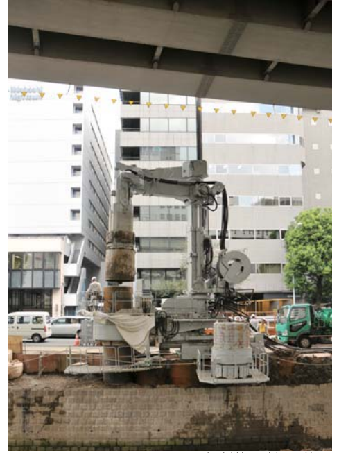
▲ 掘削装置建込み状況
