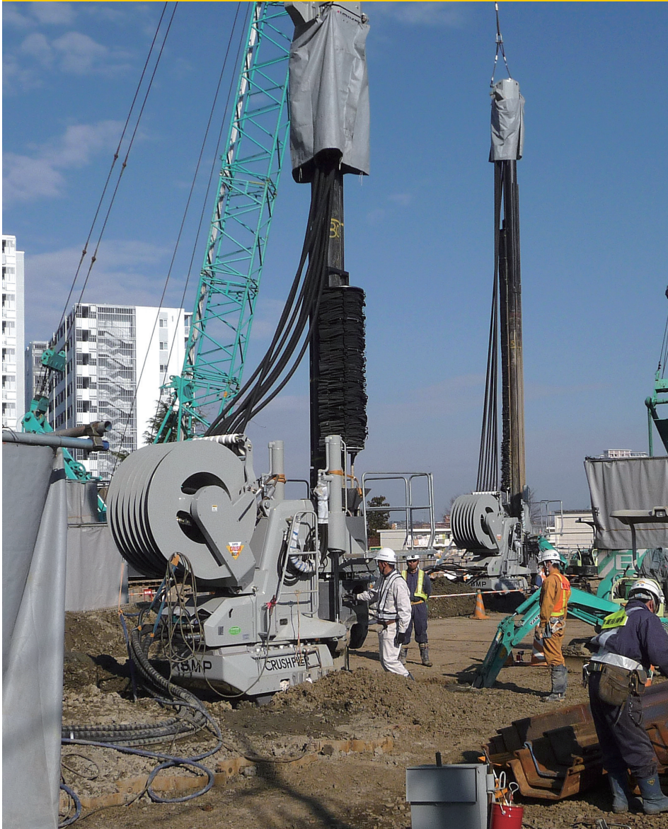
▲ 材料は現地搬入後、溶接して吊込みを行う
