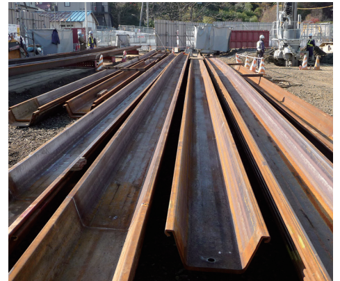
▲ 材料は現地搬入後、溶接して吊込みを行う
