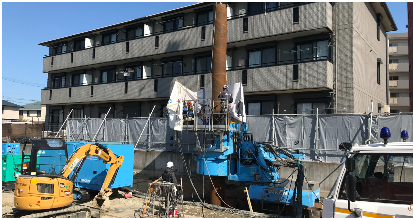
住宅地での近接施工
