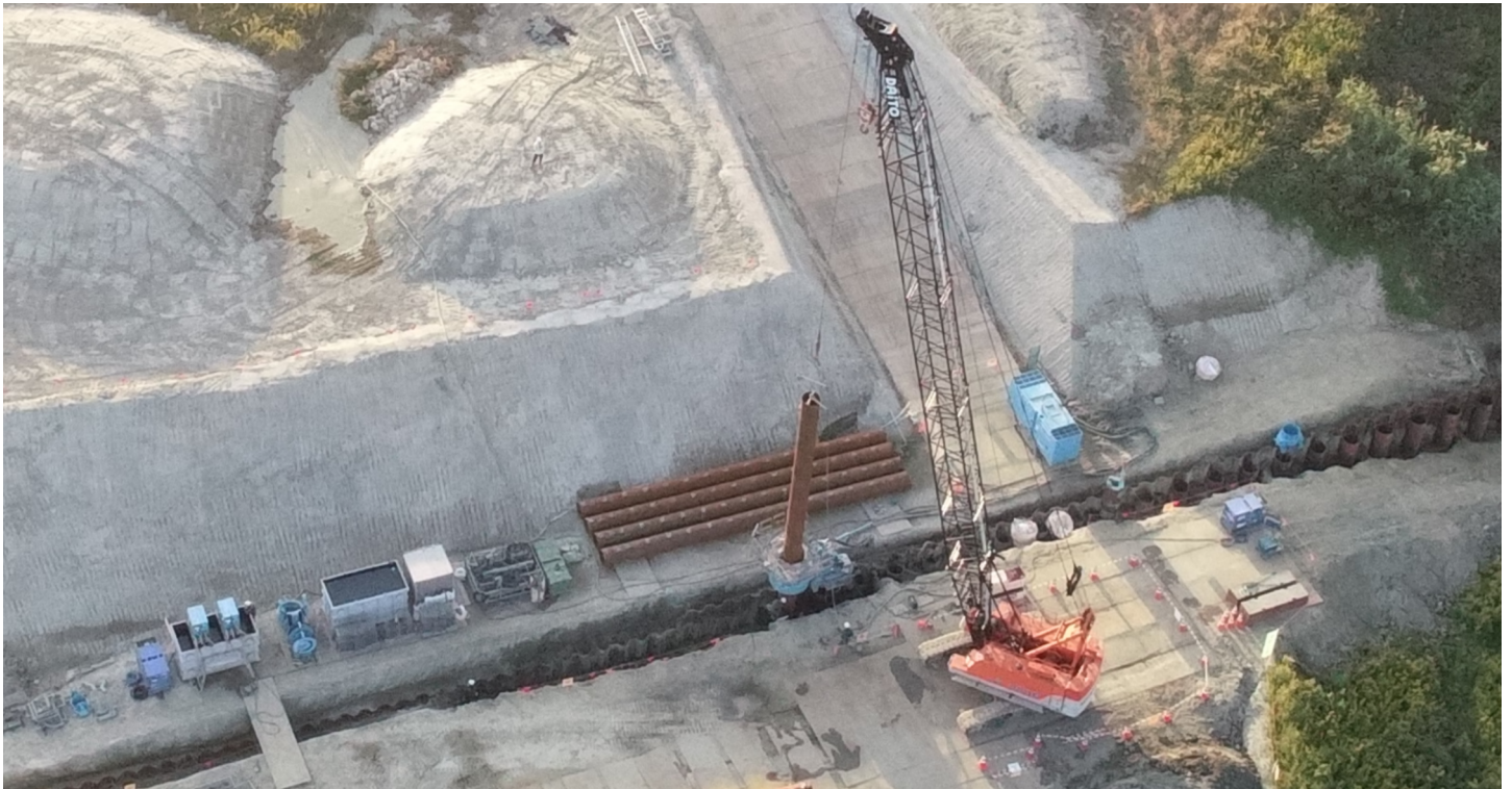
施工箇所遠景
