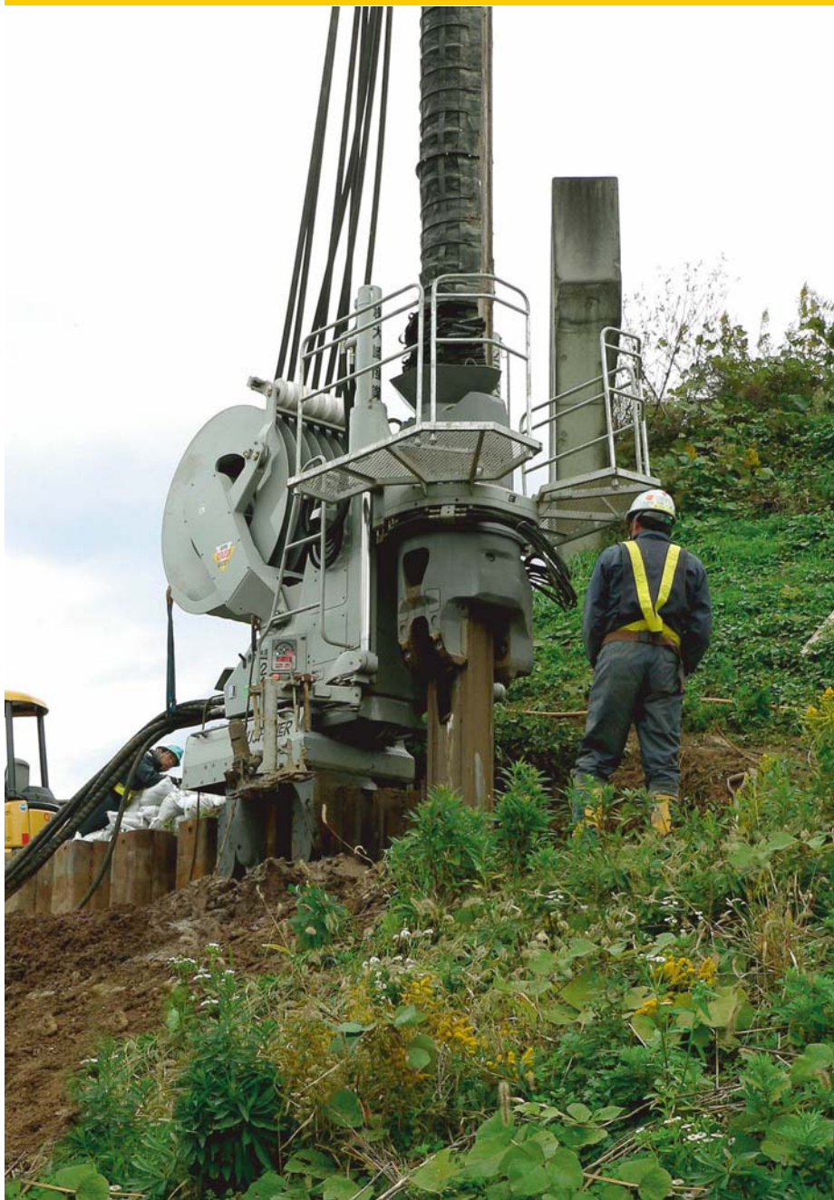
▲ 圧入機の特性を生かした傾斜地での施工
