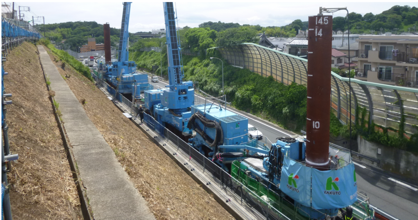
施工状況全景
