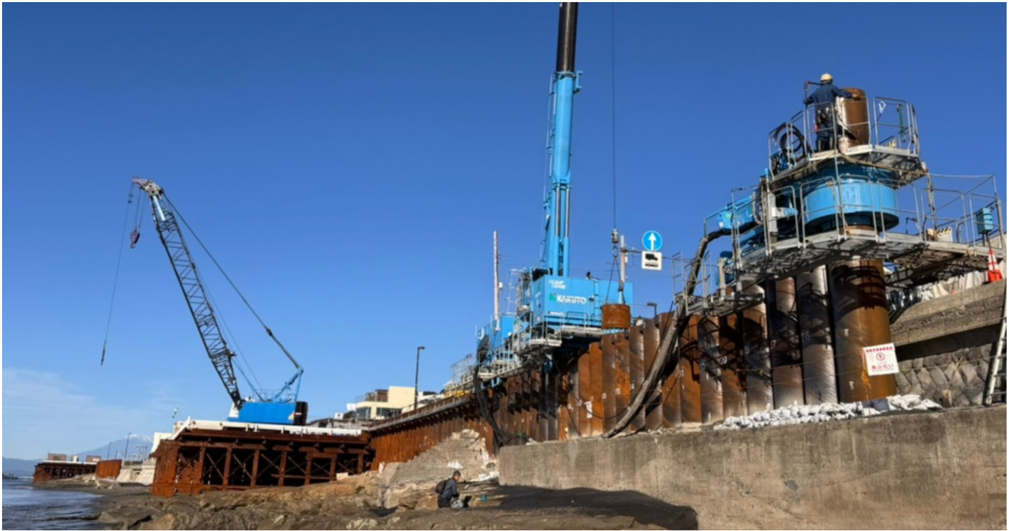
施工状況全景
