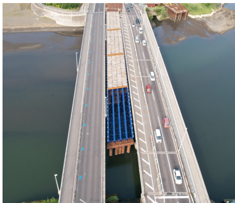
仮橋設置完了
