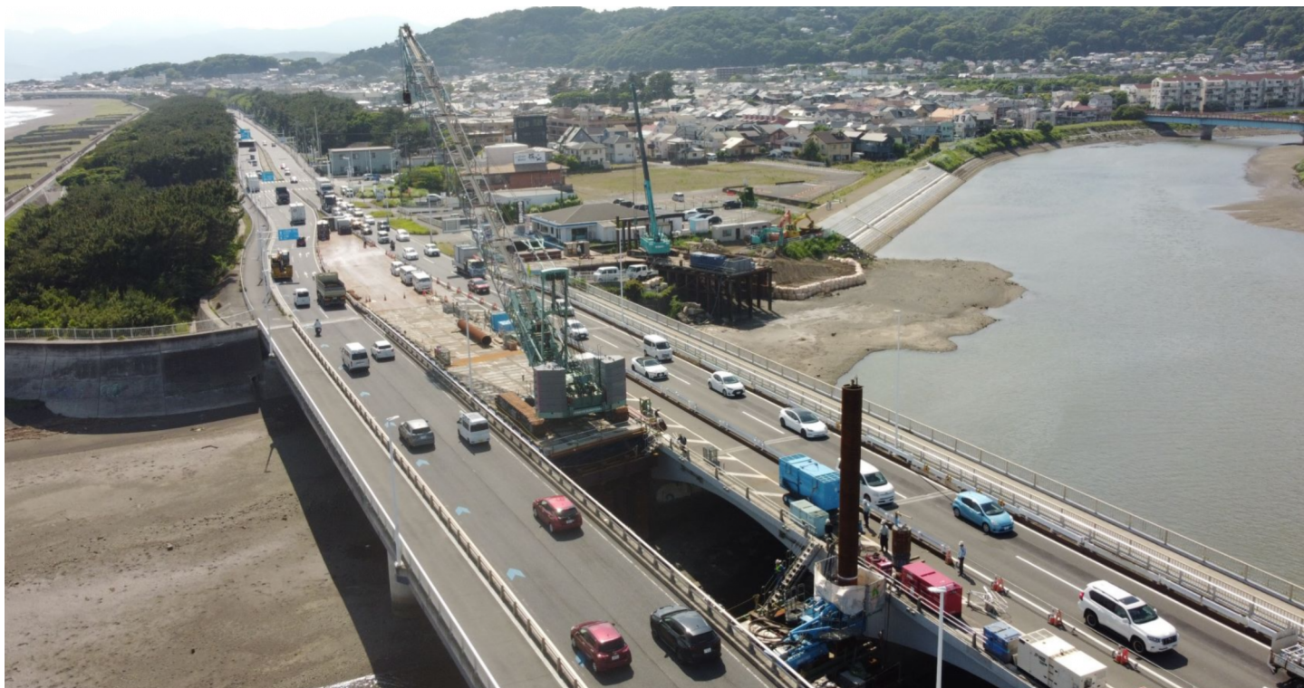
鋼管杭施工状況
