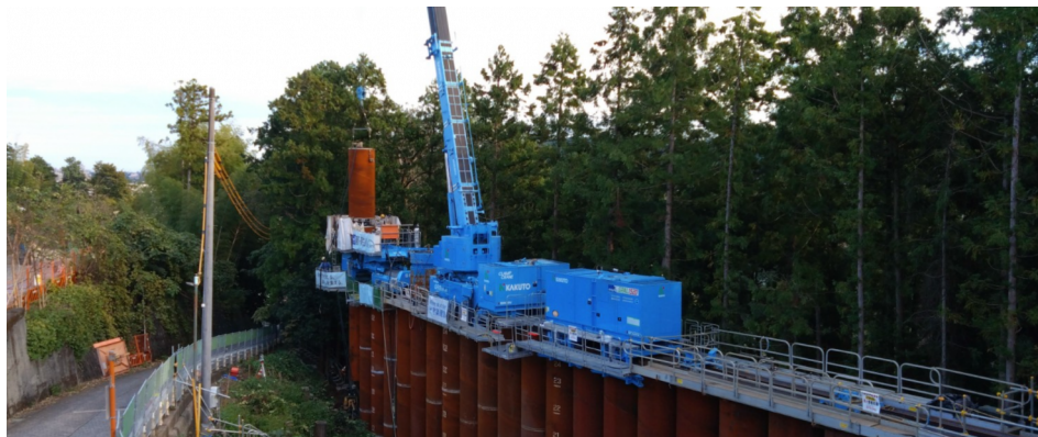
φ 1500 GRB施工部
