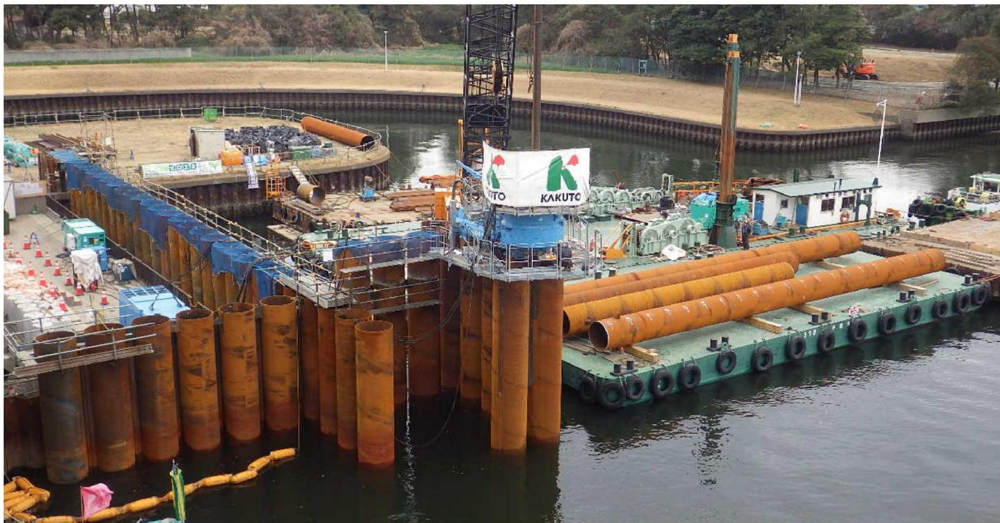
水上施工にて締切施工
