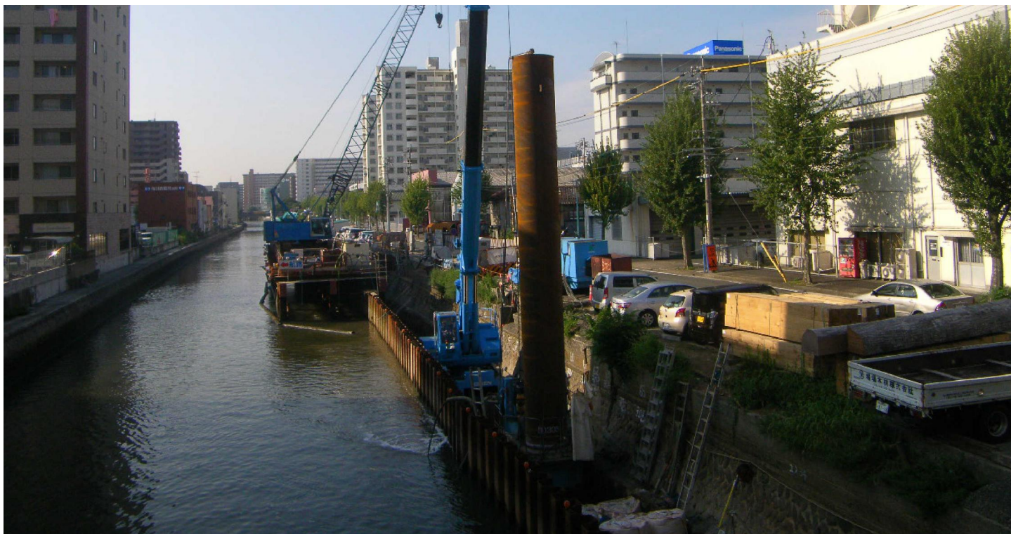
仮締切内でのGRB施工
