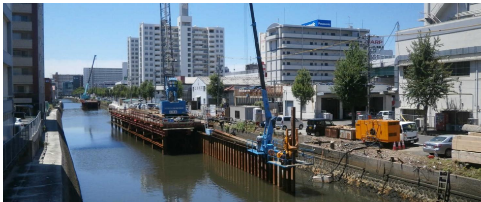
仮締切鋼矢板施工状況
