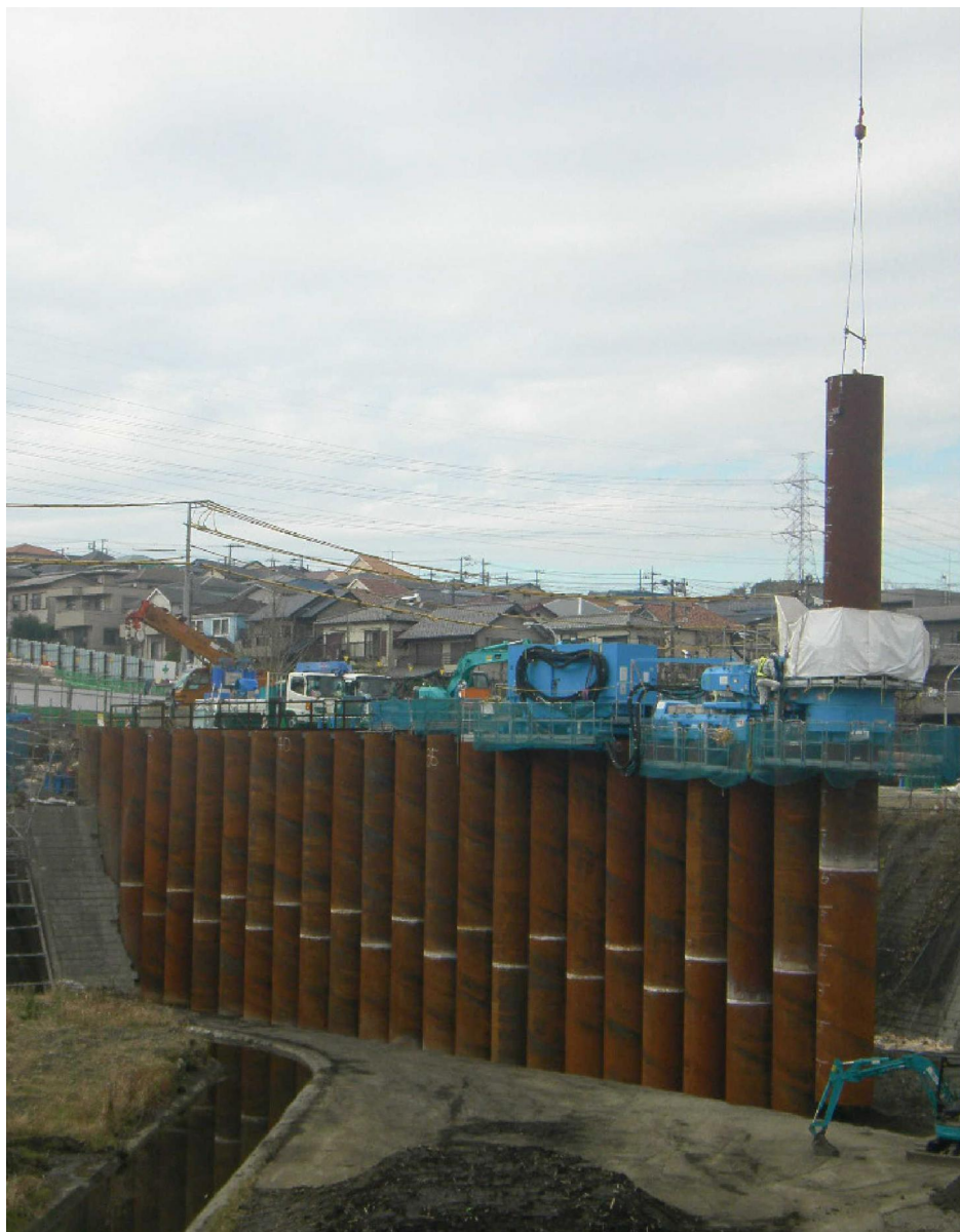
施工全景 10m高天端施工
