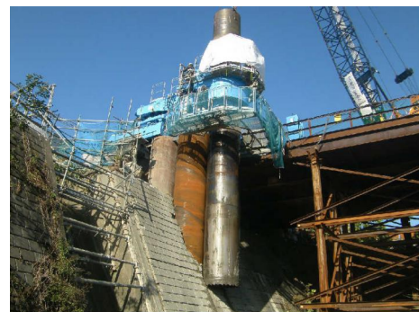
既設擁壁部先行削孔杭使用
