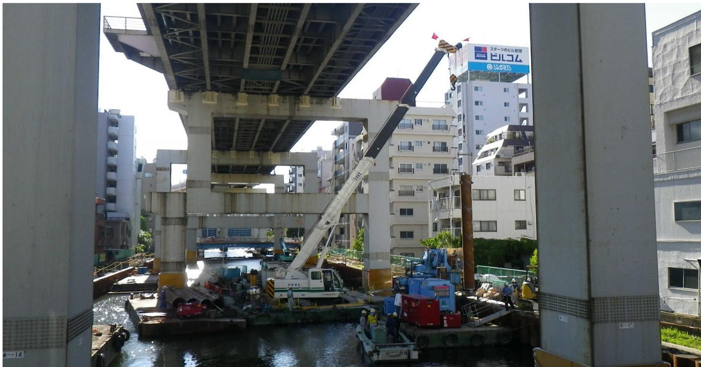
クレーン付台船による水上施工
