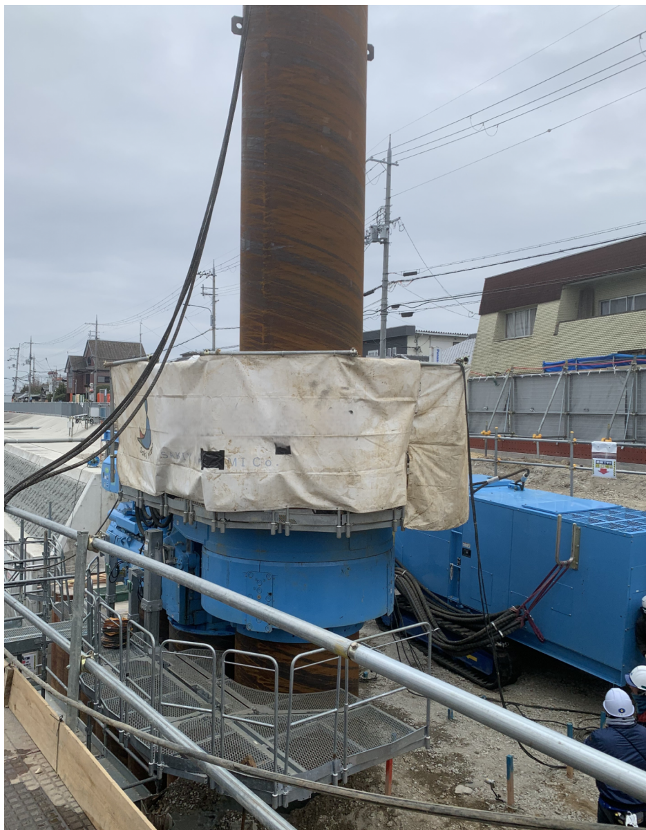
圧入状況①
