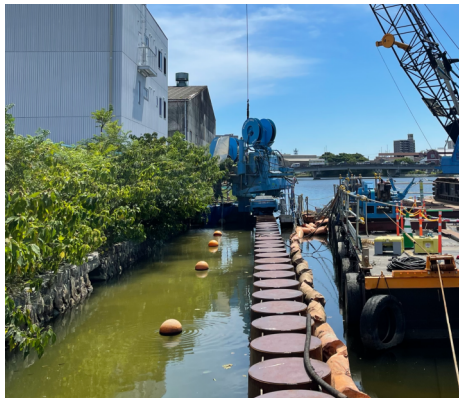
施工完了直前
