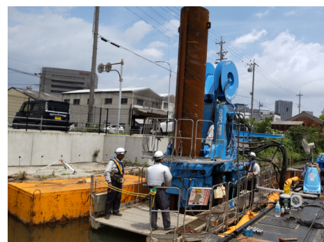
鋼管矢板圧入状況
