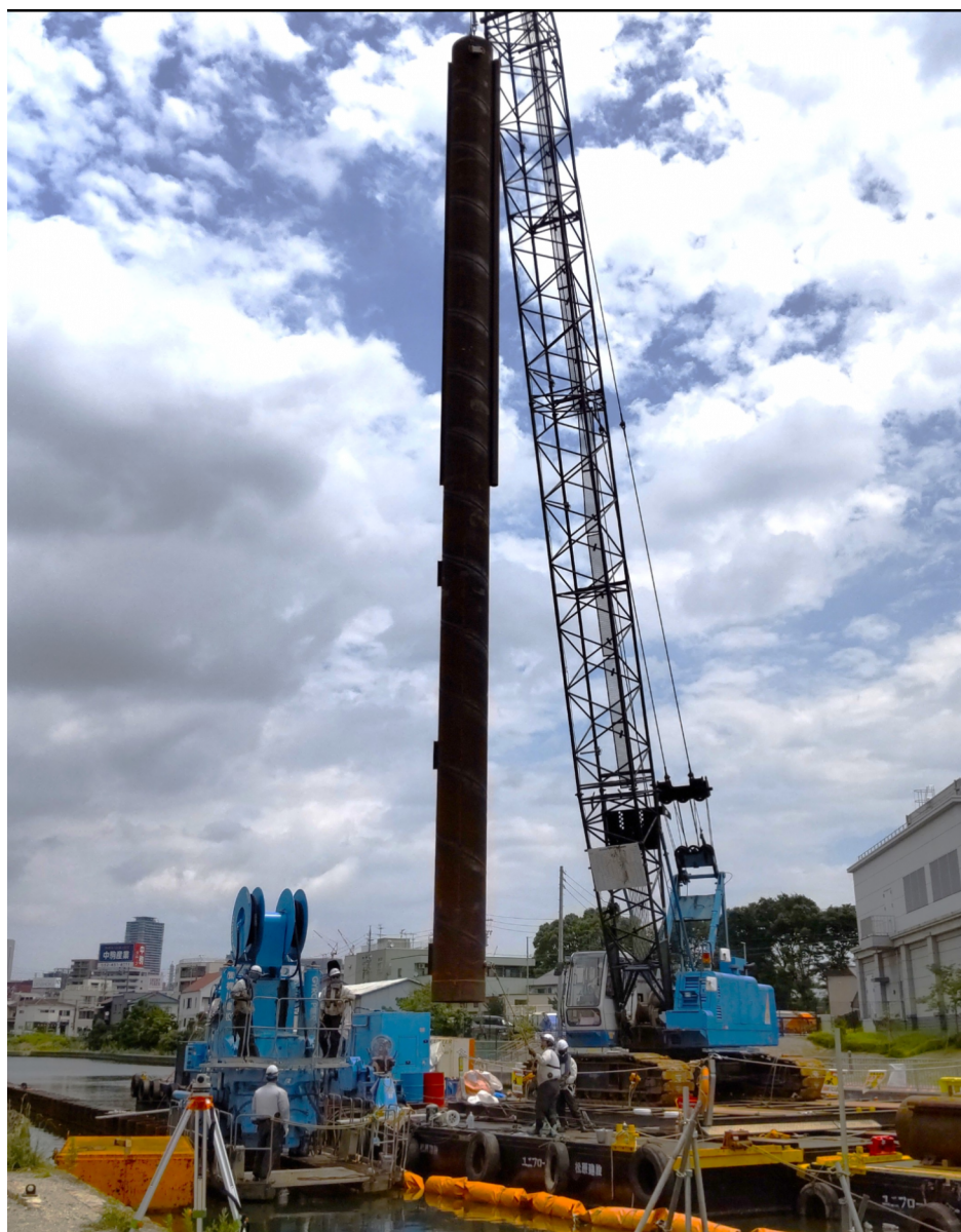
Φ900 L=19.8m の鋼管矢板を施工、50 t 吊クレーン台船で建て込み
