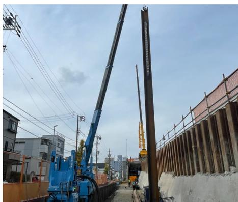
クランプクレーンによる排水矢板吊り上げ
