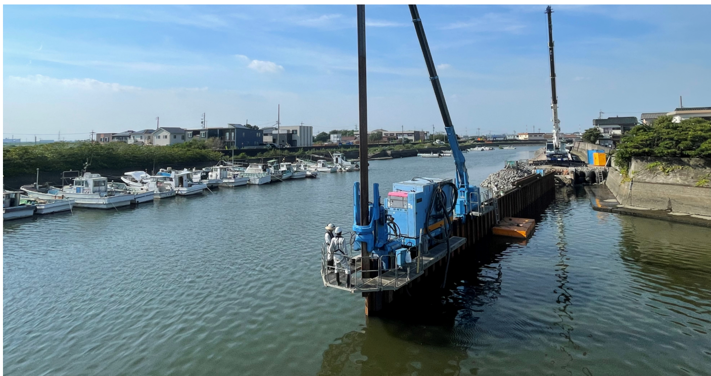
GRB施工状況
