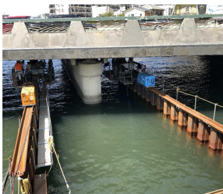
3.全体写真（2台施工）
