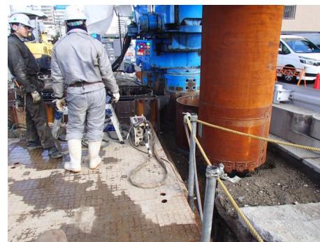
先行削孔状況
