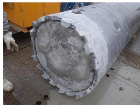
先行削孔杭で取り除いた既設コンクリート構造物
