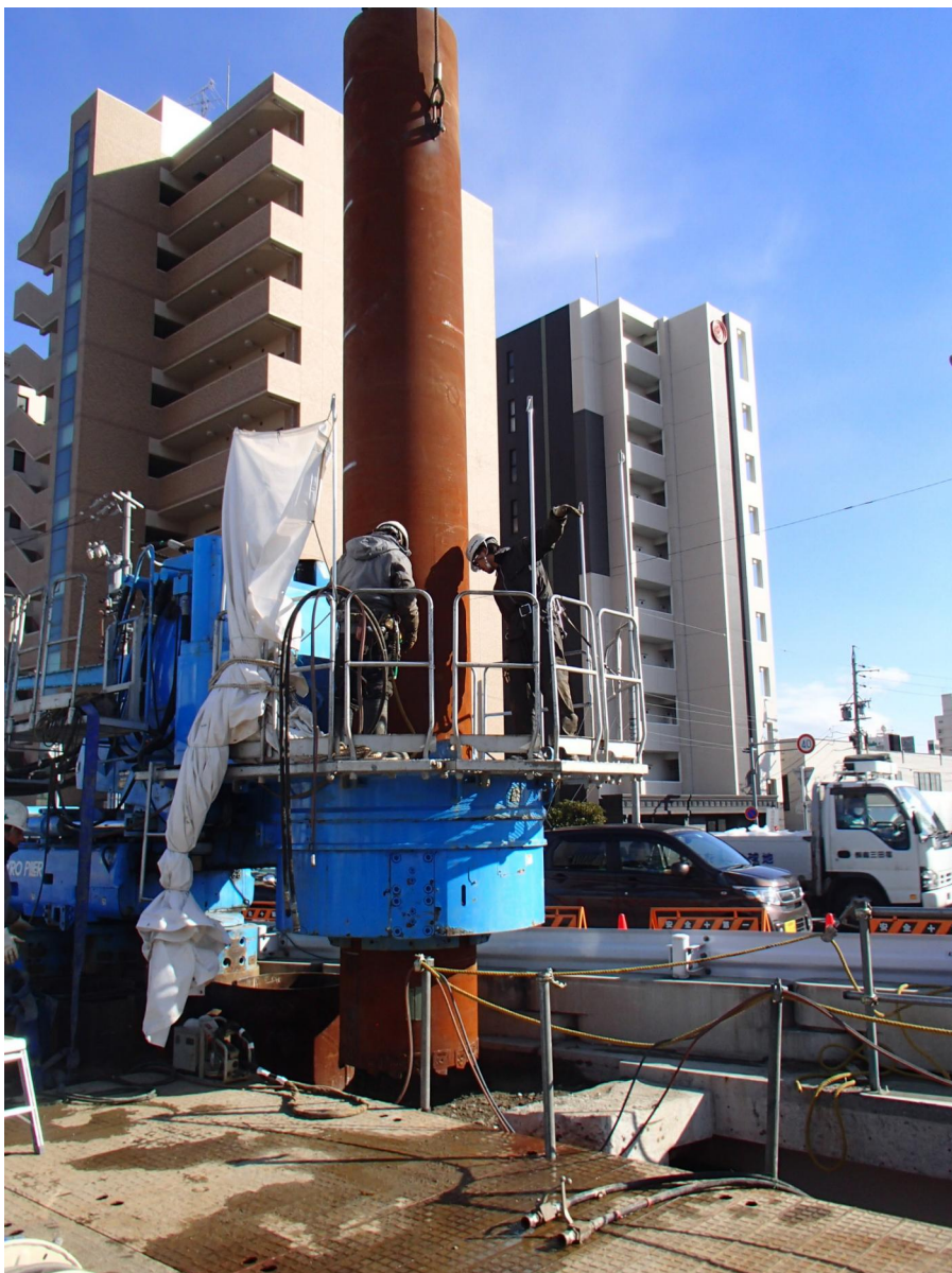
道路に近接してのジャイロプレス施工
