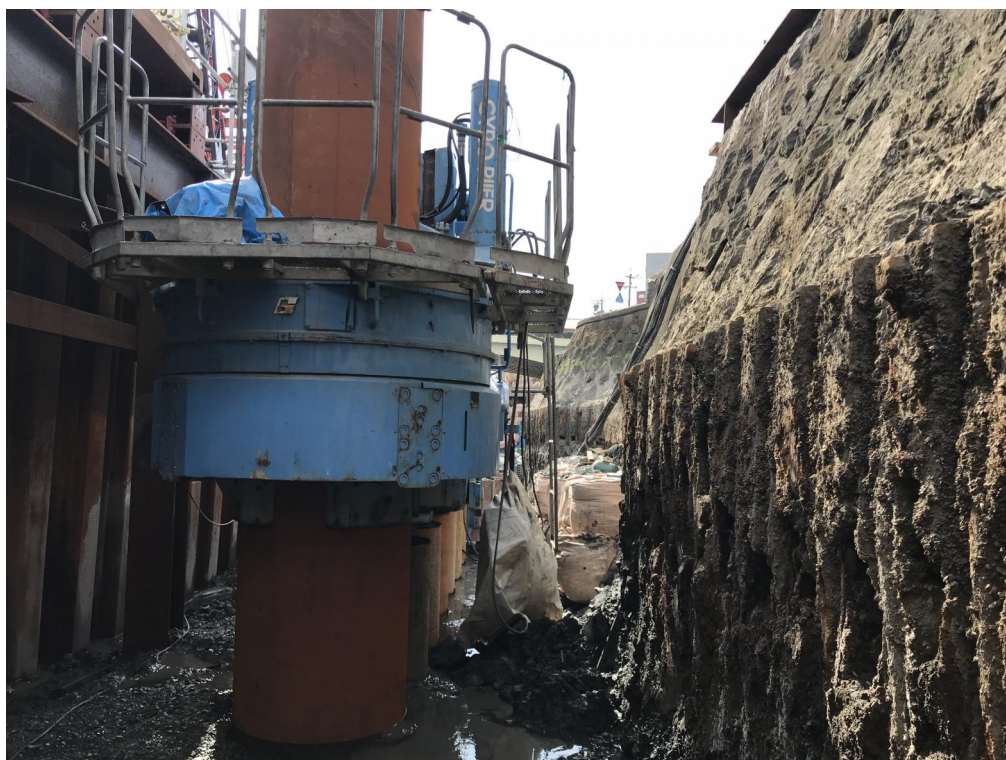
鋼管杭圧入状況
