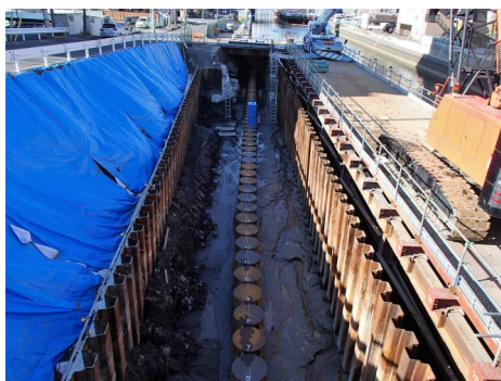
右岸施工完了後
